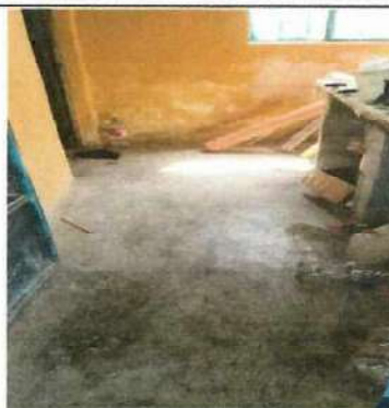
Foto 8: Instalación de piso ceramico interior dirección, debido al deterioro del piso de concreto.
