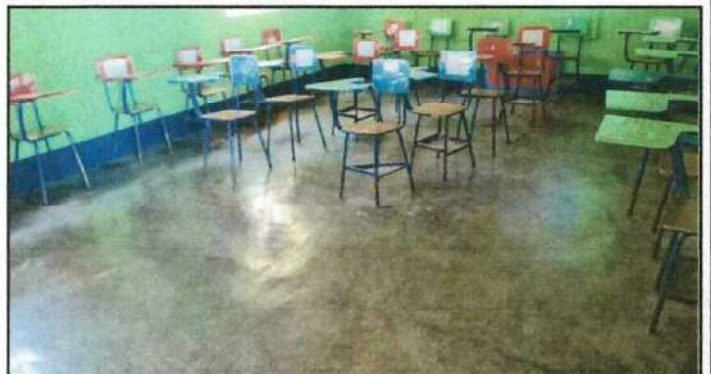
Foto 4: Instalación de piso ceramico interior del aula, debido al deterioro del piso de concreto.
