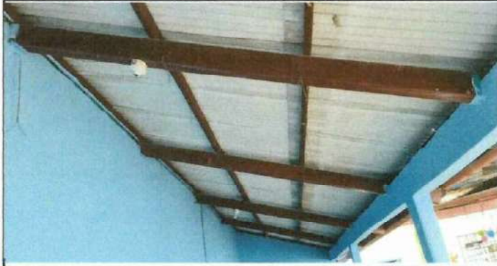
Foto 1: Mantenimiento de estructura metalica debido al deterioro de la misma para mayor durabilidad.
