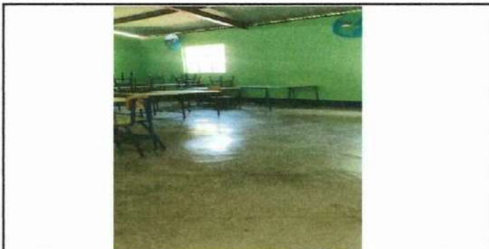
Foto 5: Instalación de piso ceramico interior del aula, debido al deterioro del piso de concreto.
