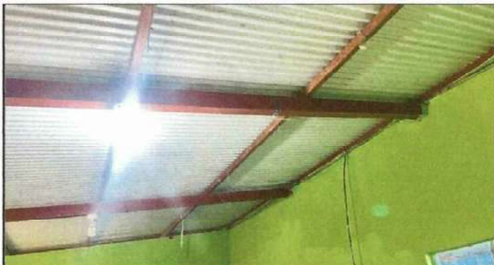
Foto 3: Instalación de cielo falso conforme a forma de techo, para mejorar las condiciones de ambiente dentro del aula.
