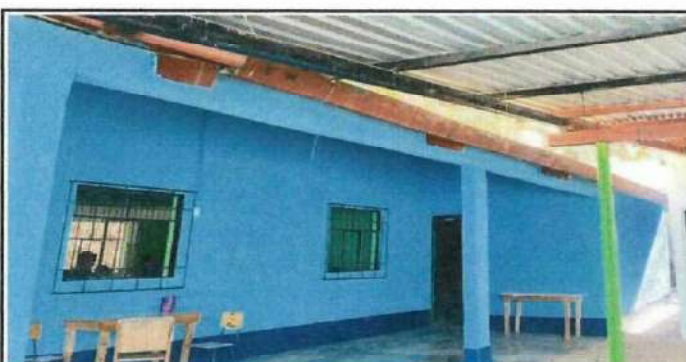
Foto 12: Mantenimiento de balcones de metal y mejoramiento de ventanas a pvc para mayor ventilacion dentro de todos los ambientes.
