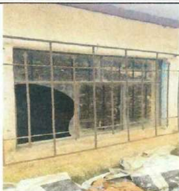
Foto 13: Mantenimiento de balcones de metal y mejoramiento de ventanas a pvc para mayor ventilacion dentro de todos los ambientes.
