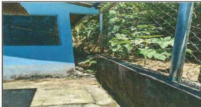
Foto 19: Reforzamiento de muro colindante (circulación) con cemento de piedra y muro de block, debido al deterioro del mismo.
