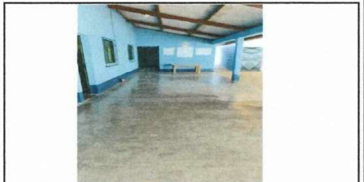
Foto 6: Instalación de piso ceramico corredor de aulas, debido al deterioro del piso de concreto.
