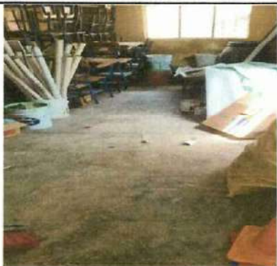
Foto 7: Instalación de piso ceramico interior dirección, debido al deterioro del piso de concreto.
