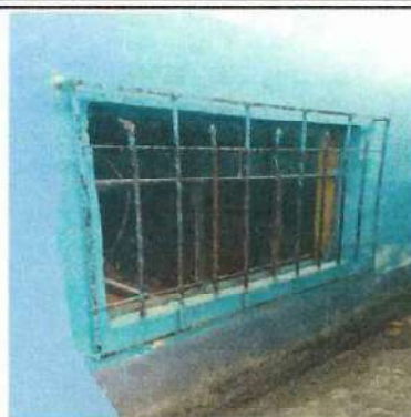
Foto 14: Mantenimiento de balcones de metal y mejoramiento de ventanas a pvc para mayor ventilacion dentro de todos los ambientes.
