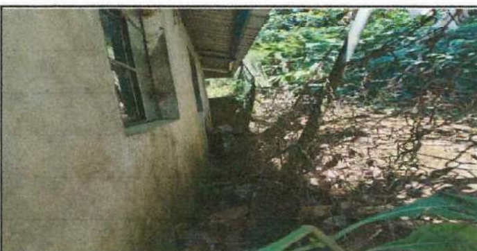
Foto 18: Reforzamiento de muro colindante (circulación) con cemento de piedra y muro de block, debido al deterioro del mismo.
